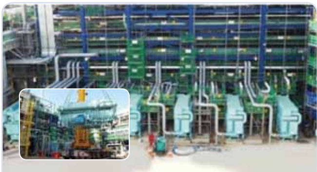
삼성토탈 중기식2중효용흡수냉동기, 저온수흡수냉동기 6대 (총 9,787usRT)
