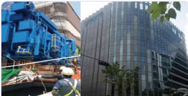
판교 한화 R&D 센터 고효율저온수2단흡수냉동기 2대 (총 840usRT)
