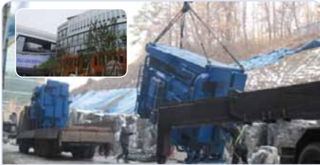
판교산학연 R&D 센터 고효율저온수2단흡수냉동기 2대 (총 480usRT)
