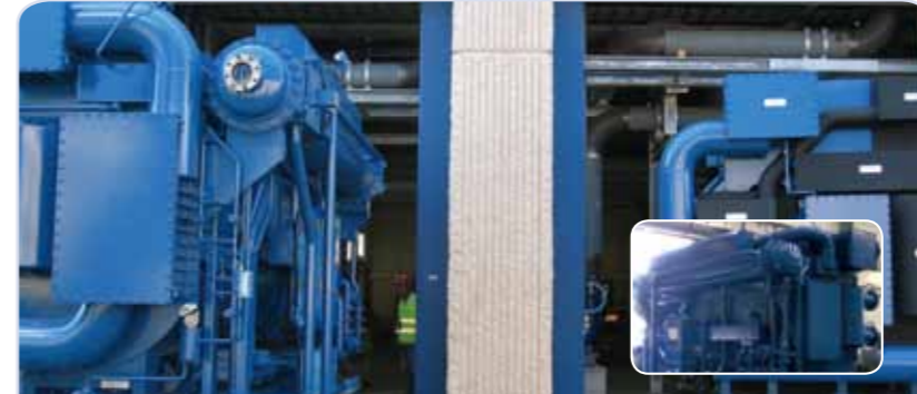
이탈리아 3SUN Group Catania Cogeneration Plant project 증기흡수냉동기, 저온수2단흡수냉동기 2,388usRT
