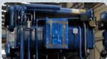
독일 Germany Rangau&Hallerwiesen Hospital 설치 저온수흡수냉동기 156.5usRT 3대
