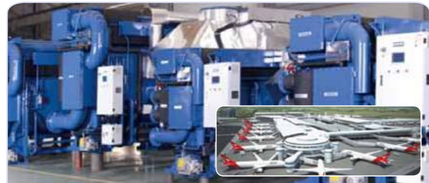
호주 시드니 Qantas Trigen 배기가스흡수냉동기 320usRT 2대, 배기가스흡수냉동기 1,000usRT 2대, 저온수흡수냉동기 825usRT 1대, 470usRT 1대
