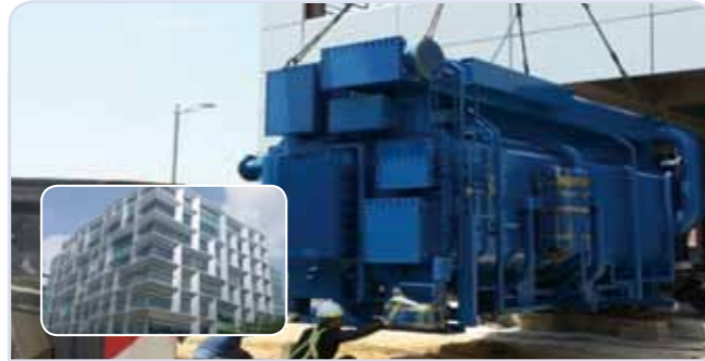
판교삼양 R&D 센터 고효율저온수2단흡수냉동기 2대 (총 680usRT)
