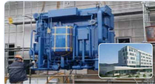
한국승강기안전관리원 (진주) 고효율저온수2단흡수냉동기 2대 (총 150usRT)
