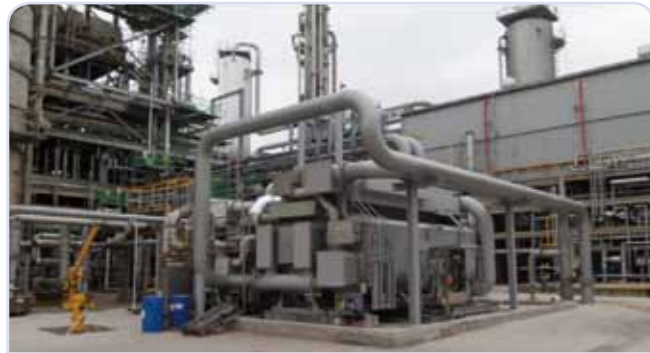
대산 롯데케미칼 D-EG1 저온수2단흡수냉동기 1,125usRT
