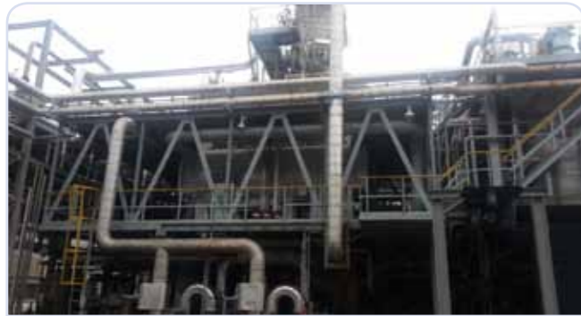
금호석유화학 흡수식히트펌프(AHT4,500H) 1.2barG 스팀 시간당 8톤 생산
