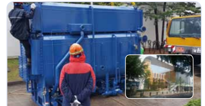
양천구 편익시설 저온수2단흡수냉동기 2대 (총 1,050usRT)
