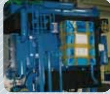
프랑스 France Piscine Sainte Manehould 설치 저온수흡수냉동기 40usRT
