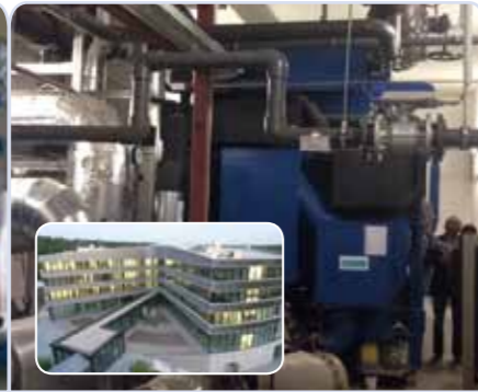
독일 BCMG EHNINGEN 저온수2단흡수냉동기 1,031usRT
