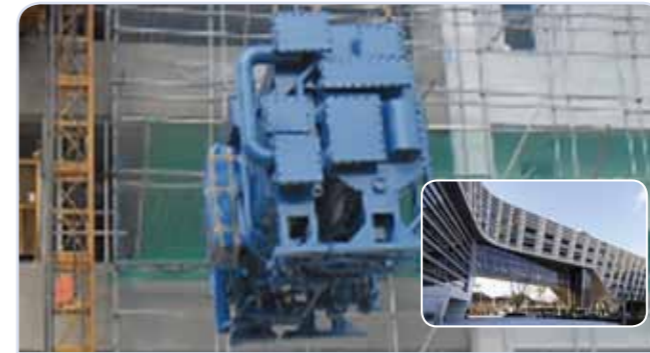
정부세종청사 3단계 1구역 고효율저온수2단흡수냉동기 2대 (총 840usRT)
