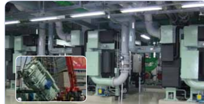
SK 판교테크노벨리 저온수2단흡수냉동기 5대 (총 2,023usRT)
