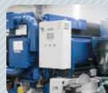
멕시코 Mexico Cashfin Energy 설치 배기가스흡수냉동기 320usRT
