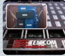
이태리 Italy Telecom 설치 저온수흡수냉동기 140usRT
