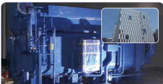
마곡 좋은책 신사고 사옥 고효율저온수2단흡수냉동기 2대 (총 520usRT)
