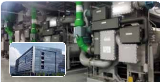
판교 U SPACE 1, 2 저온수2단흡수냉동기 9대 (총 6,295usRT)
