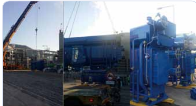
한화케미칼 PE생산1공장 흡수식냉동기 1,400usRT
