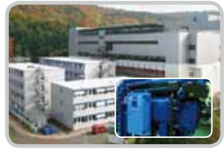
독일 Behringwerke Marburg 저온수흡수냉동기 56.9usRT
