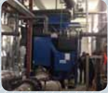
독일 Germany IBM EHINGEN 설치 저온수2단흡수냉동기 210usRT
