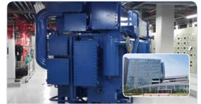
극지연구소 (송도) 고효율저온수2단흡수냉동기 1대 (210usRT)
