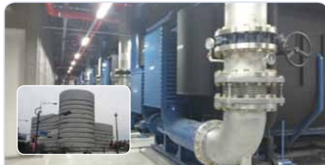
광교 CJ Onlyone R&D 센터 저온수2단흡수냉동기 6대 (총 5,400usRT)
