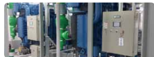
· DWHH120, 용인 평온의숲 설치 (2013년)
