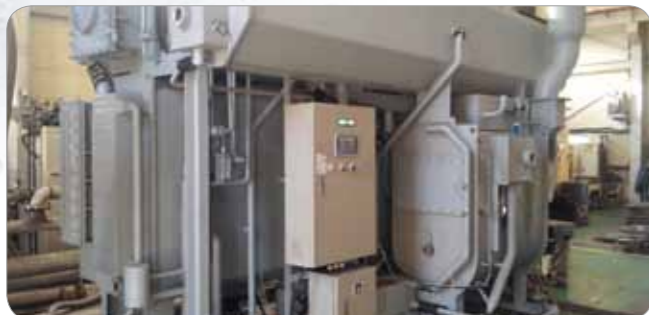
2단흡수히트펌프의 시제품 시험 (Heat pump Test)
