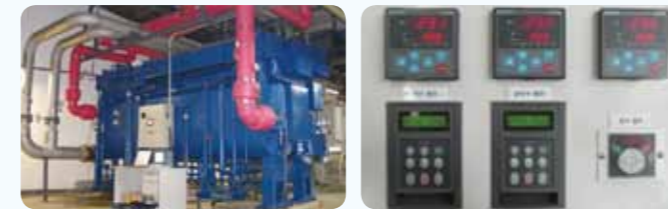
▲한국지역난방공사와 한국설비기술협회에서 용역을 의뢰받아 지역난방 온수를 이용하여 여름철에 가동할 수 있는 저온수2단 흡수냉동기를 개발
