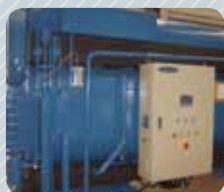
미국 United States of America British Embassy 설치 저온수흡수냉동기 86usRT
