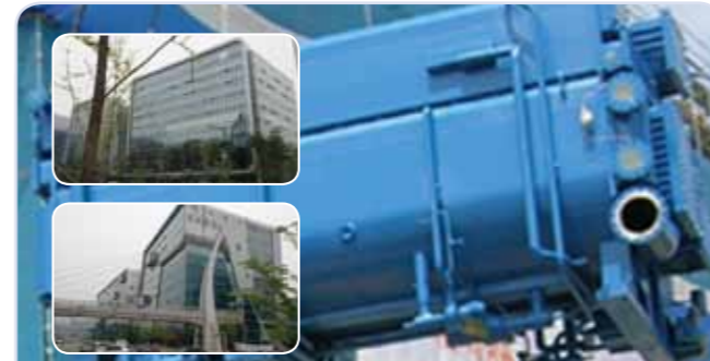
KCC 판교 이노벨리 저온수2단흡수냉동기 13대 (총 5,010usRT)
