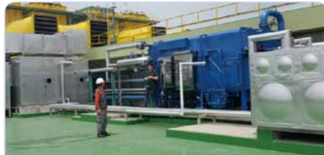
고려아연 정류기실 냉방설비 시스템 폐열회수흡수냉동기(중기 온수 겸용) 210usRT, 공기조화기(AHU), 냉수탱크, 덕트시설
