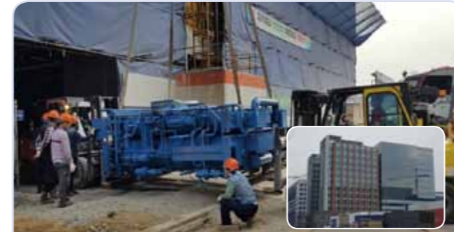
문정동 화엄빌딩 고효율2단저온흡수냉동기 2대 (총 270usRT)
