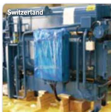
Zentralwascherei HWR-L 50usRT(176kW)
