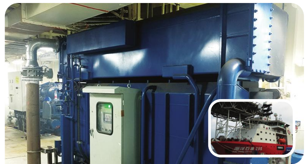
중국 Novenco Marine&Offshore 선박용 저온수 흡수냉동기 156usRT
