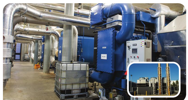
호주 Qantas Trigeration 저온수 흡수냉동기 1,295usRT / 배기가스 흡수냉은수기 2,640usRT
