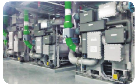
판교U SPACE 저온수2단흡수냉동기 설치
