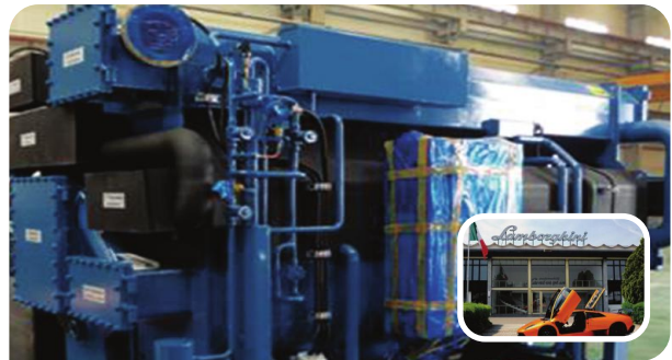
이탈리아 Lamborghini 저온수2단 흡수냉동기 137usRT
