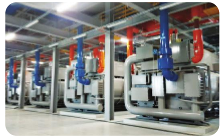
인천국제공항 저온수2단 흡수냉동기 설치
