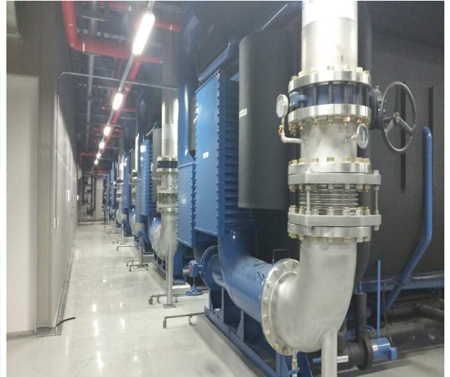
▲ CJ연구소에 설치된 흡수냉동기
