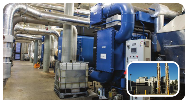
호주 Qantas Trigeration 저온수 흡수냉동기 1,295usRT / 배기가스 흡수냉은수기 2,640usRT
