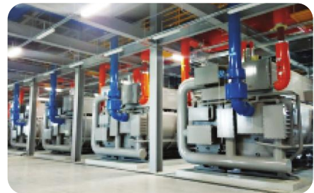
인천국제공항 저온수2단 흡수냉동기 설치
