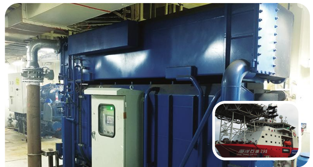
중국 Novenco Marine&Offshore 선박용 저온수 흡수냉동기 156usRT
