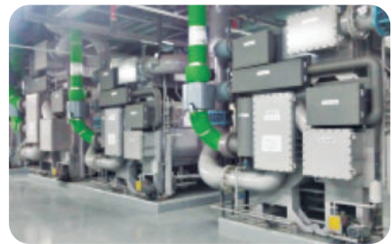
관교U SPACE 저온수2단흡수냉동기 설치
