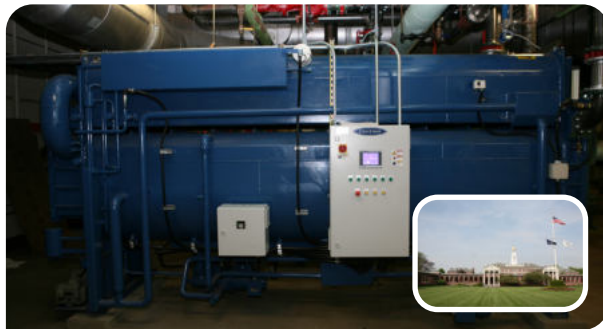
미국 Burke Rehabilitation Hospital 저온수 흡수냉동기 150usRT
