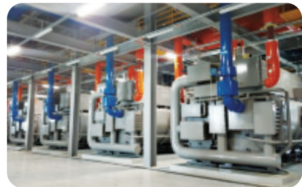
인천국제공항 저온수2단 흡수냉동기 설치
