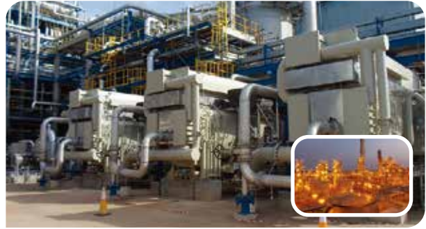
태국 TOC Glycol 저온수 흡수냉동기 270usRT
