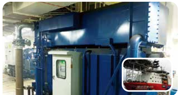
중국 Novenco Marine&Offshore 선박용 저온수 흡수냉동기 156usRT
