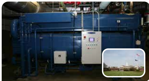
미국 Burke Rehabilitation Hospital 저온수 흡수냉동기 150usRT
