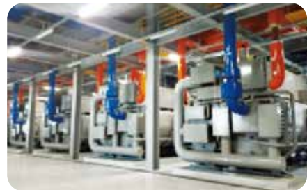
인천국제공항 저온수2단 흡수냉동기 설치
