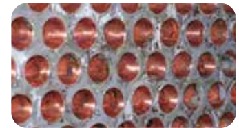
전열관 무세관 시스템 설치
