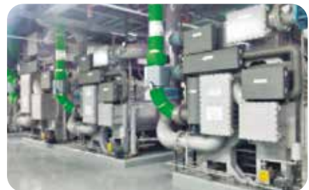
판교U SPACE 저온수2단흡수냉동기 설치
