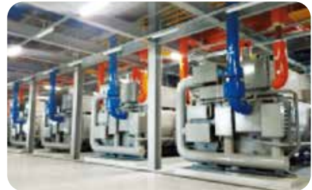
인천국제공항 저온수2단 흡수냉동기 설치
