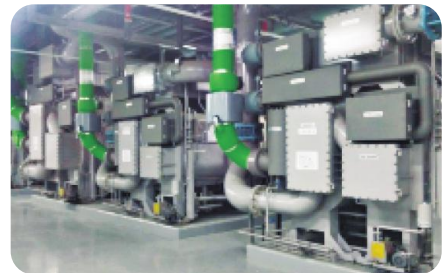
판교U SPACE 저온수2단흡수냉동기 설치
