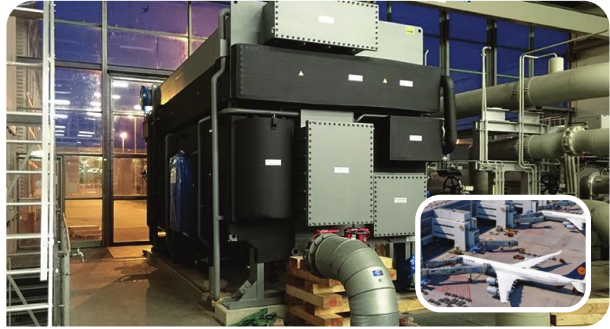
독일 Munich International Airport 저온수2단 흡수냉동기 975usRT
