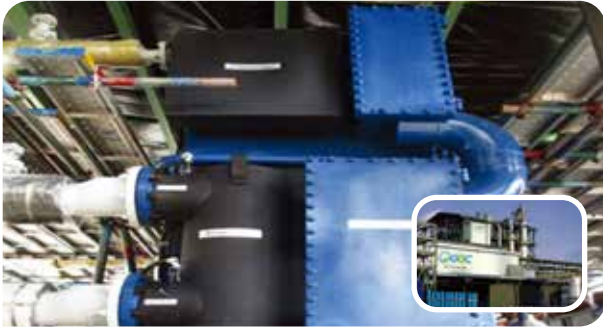
태국 Global Green Chemicals Plc 저온수 흡수냉동기 270usRT
