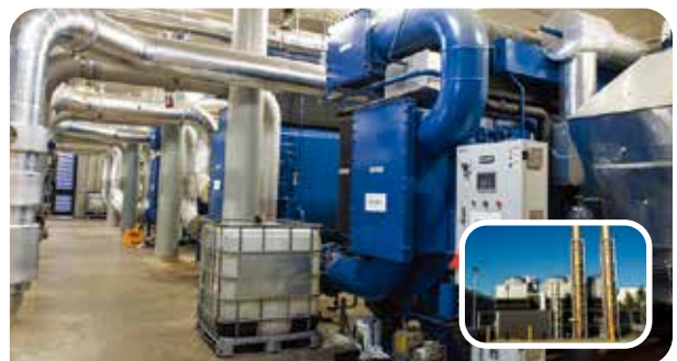
호주 Qantas Trigeration 저온수 흡수냉동기 1,295usRT / 배기가스 흡수냉운수기 2,640usRT
