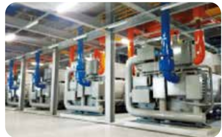
인천국제공항 저온수2단 흡수냉동기 설치
