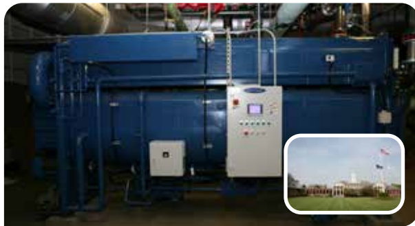
미국 Burke Rehabilitation Hospital 저온수 흡수냉동기 150usRT
