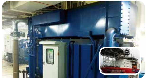
중국 Novenco Marine&Offshore 선박용 저온수 흡수냉동기 156usRT
