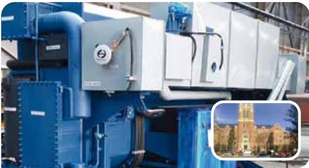
미국 Canandaigua VA Medical Center 증기식 2중효용 흡수냉동기 400usRT
